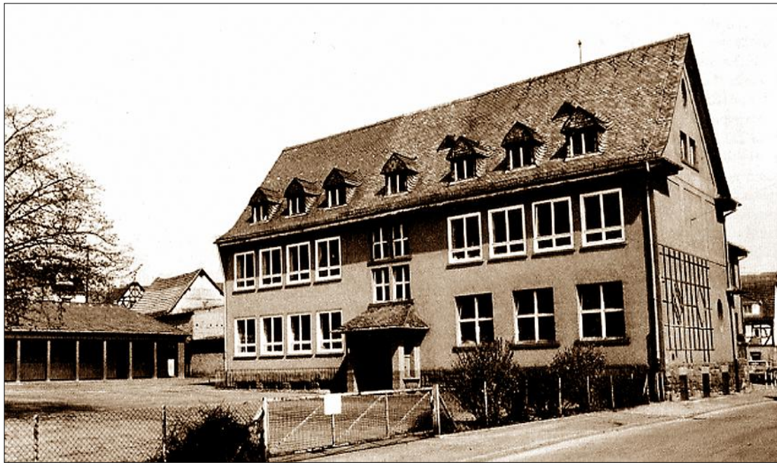
Abb. 4: 3. Schule 1915 bis 1969 (54 Jahre) an der Schulstraße
